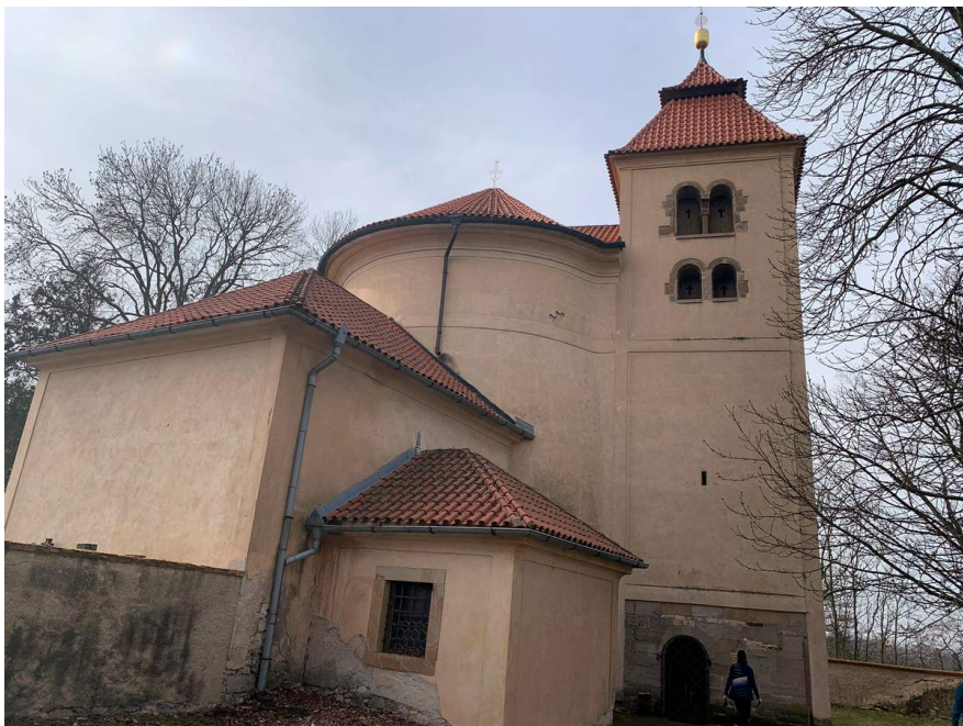
Budeč celý kostel i s rotundou
